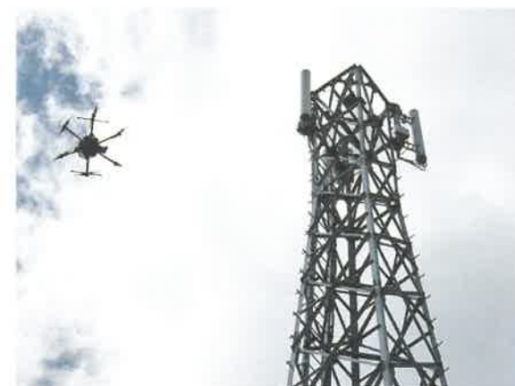
図19 ドローンによる基地局監視
